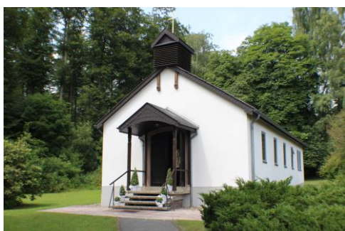
(Schäferberg Kapelle, Außenansicht)
